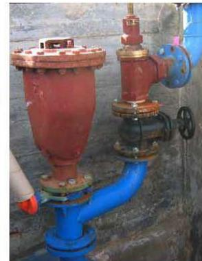
**Colocación:** Puede funcionar en cualquier posición: vertical, horizontal o inclinada.
