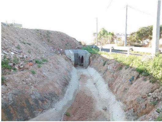
*Paso del canal bajo vial acceso viviendas y entrada al sector mediante ODT: 2HA1200*
