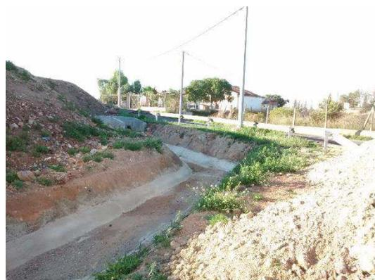
Canal de Hormigón excavado de sección cuasirectangular variable (0,1 tr)
