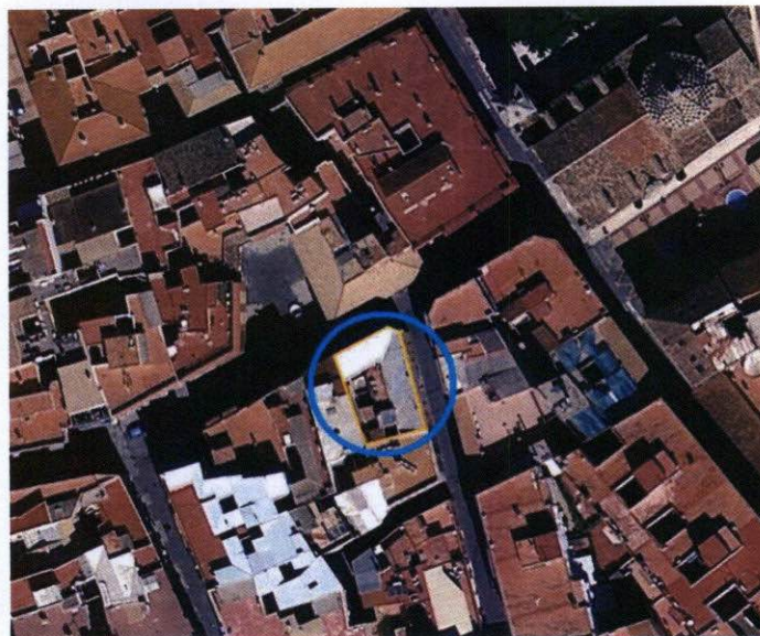
Situación del inmueble actual. GOOGLE MAPS 2.017
