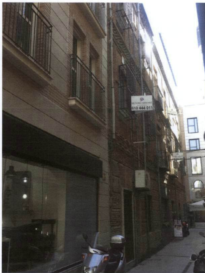
06-VISTA CALLE PELIGROS LADO IZQUIERDO
