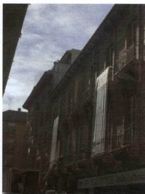
03-VISTA LADO IZQUIERDO CALLE PINAR
