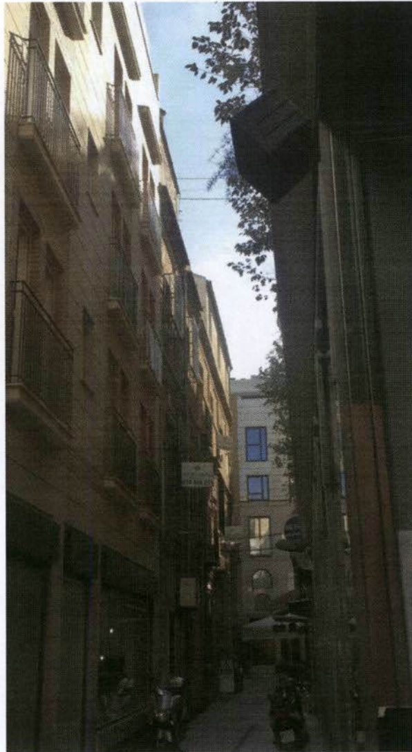
04-VISTA CALLE PELIGROS
