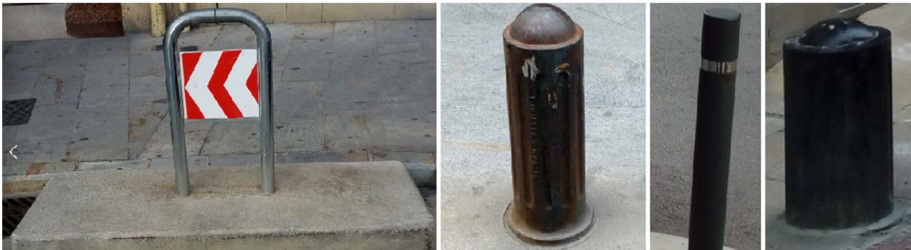
Tipologías de bolardos existentes en el ámbito.
