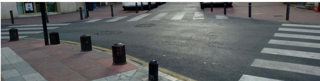
Diferentes tipologías de bolardos en intersección. Constituye un elemento distorsionador para el entorno.
