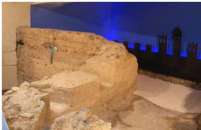
Con graves problemas de contaminación, la muralla estaba totalmente cubierta por una capa negra de depósitos producidos por la combustión de los motores. El tratamiento consistió en limpieza con agua vaporizada a presión y consolidación con numerosas capas de agua de cal. Una musealización llamativa del espacio ayudó para que dejara de ser invisible y los ciudadanos descubrieran este bien cultural andalusí.
