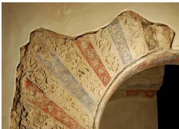
Debido a la humedad producida por capilaridad existían disgregaciones de material. Para la consolidación y fijación de morteros y enlucidos se optó con resultados satisfactorios por el empleo de consolidantes a base de silicato de etilo, mortero de inyección exento de sales, resinas acrílicas en baja proporción y refuerzos estructurales a través de la inserción de varillas de fibra de vidrio.
