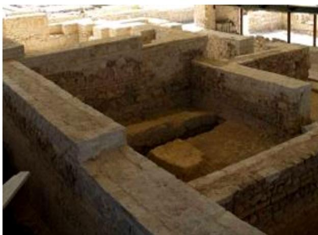
*Elevación parcial o alzado volumétrico de estructuras arqueológicas para aportar unidad estructural, formal y estética, permitir una mejor comprensión de determinados recintos y facilitar la visualización de las características esenciales de la arquitectura.*
