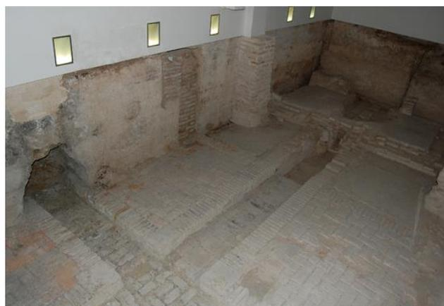
Debido a la humedad producida por capilaridad existían disgregaciones de material. Para la consolidación de morteros, ladrillos, enlucidos y suelos de cal y arena se han empleado con resultados satisfactorios consolidantes a base de silicato de etilo, resinas acrílicas en dispersión acuosa en baja proporción y un consolidante a base de hidróxido de calcio en dispersión en alcohol isopropílico (Nanotecnología de cal).
